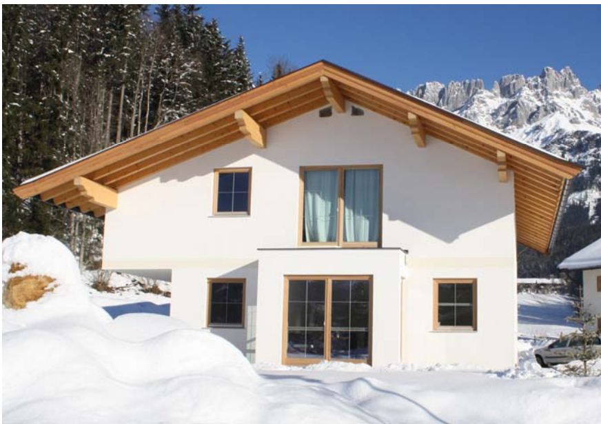
Bild 1 Sprossenverglasung im Neubau
