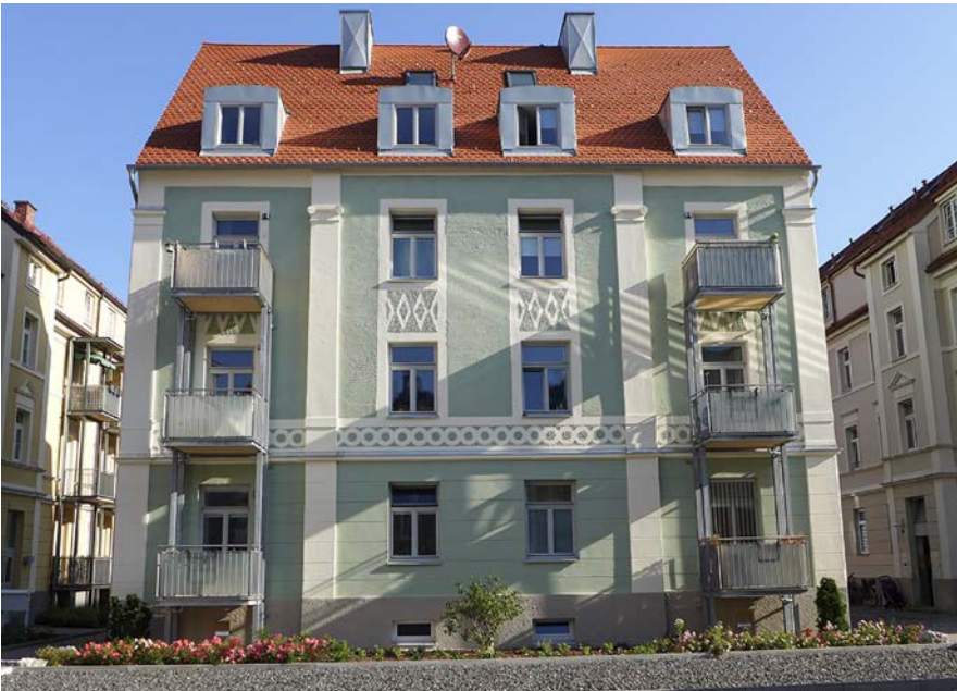
1 Mit Passivhauskomponenten sanierte historische Arbeiterwohnsiedlung Füssen
