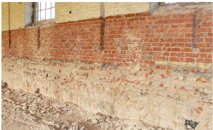
2 Nach Entfernen des Bestandputzes kommen in der oberen Wandhälfte Ziegel, in der unteren Wandhälfte Natursteine zu Vorschein. Hier wird ein Ausgleichsputz benötigt.
