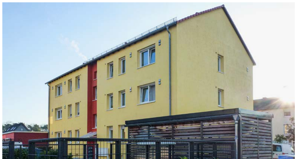
5 Erstes Nullheizkostenhaus im hessischen Pfungstadt im Passivhausstandard (Bauherr: GeWoBau Pfungstadt)
