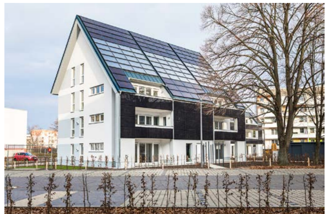
3 Heutige Fassaden definieren sich nicht mehr über Ornamentik, sondern übernehmen Funktion: Sie schützen vor Wärmeverlust und erzeugen Strom.
